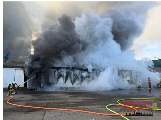
Abbildung 49-Brand im Biomasse-Heizkraftwerk am 14.03.2025
